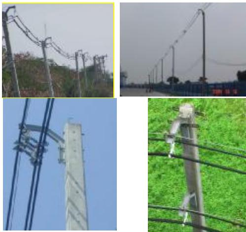
استفاده قرار گیرند. کابل‌های فاصله دار در ولتاژهای فوق توزیع و در سطح ولتاژ ۶۹ کیلو نیز بکار برده شده اند. این شبکه به ویژه بمنظور کاهش حریم مورد استفاده قرار گرفته است [۵]. تجربیات شرکت CEMIG برزیل نشان داده است که با استفاده از کابل فاصله دار می‌توان نرخ عیب را از  $0.9/0$  عیب در هر کیلومتر در سال برای شبکه‌های توزیع با هادیهای لخت به  $0.4/0$  عیب در هر کیلومتر در سال کاهش داد [۶-۷].
