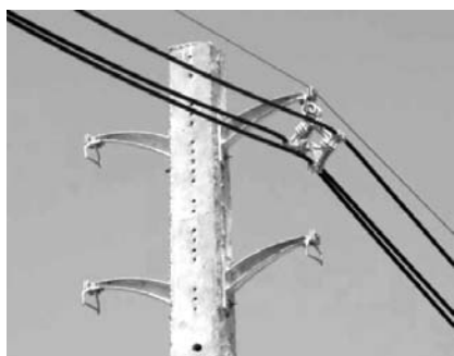
ب- فاصله نگهدارهای نصب شده در روی پایه عبوری
