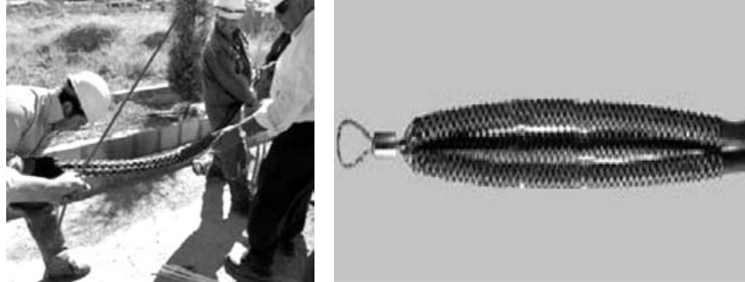
شکل ۱۱- جوراب کابل‌کشی و نحوه به‌کارگیری آن
