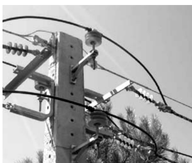
ب- به‌کارگیری کنسول جانبی در پایه کششی
