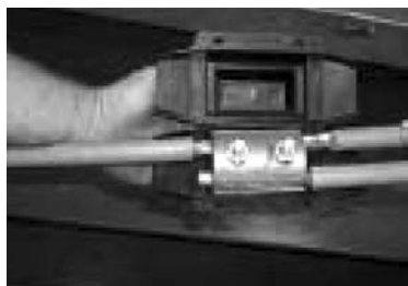
شکل ۵۲- نحوه بستن کلمپ دو شیاره و قرار دادن محفظه عایقی مربوطه
