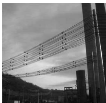
الف- هشت مدار بر روی یک پایه
