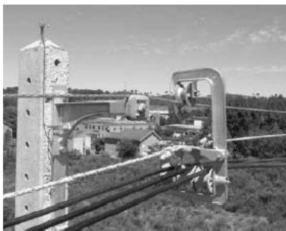
ب- عبور قرقره سه تایی از روی گلگی پایه عبوری
