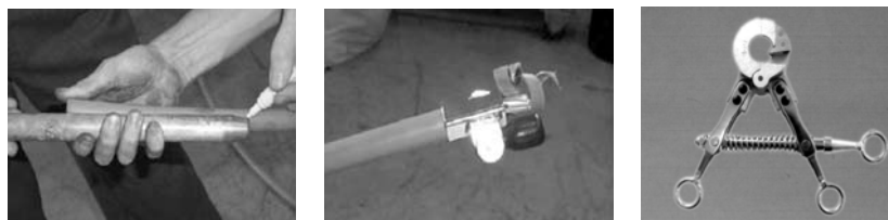
الف- کابل لخت کن ب- اندازه‌گذاری ج- روکش‌برداری
