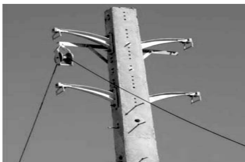
شکل ۱۰- سیم سیم کش و نحوه بکارگیری آن
