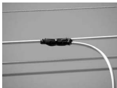
۳۷- انشعاب‌گیری از هادی روکش‌دار سه لایه در شبکه کابل فاصله‌دار
