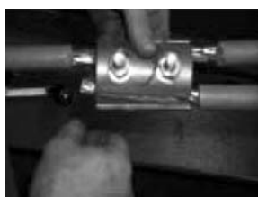
شکل ۵۰- اتصال با استفاده از پرس هیدرولیکی ۵۱- نحوه به کارگیری کلمپ های دو شیاره
