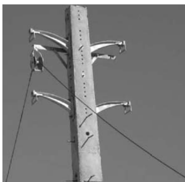
شکل ۵۳- نصب قرقره هوایی بر روی کنسول کمکی در روش اجرای سکشن‌های کوتاه
