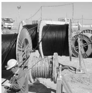
الف- استقرار قرقره‌های کابل فاصله‌دار در ابتدای مسیر
