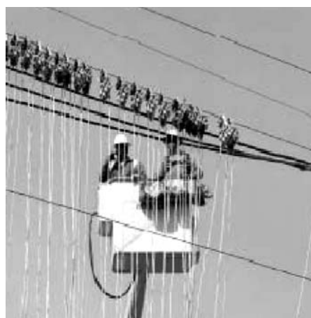
الف- نصب و تنظیم قرقره تکی و قرقره‌های سه تایی دنباله رو
