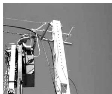
الف- انتهایی کردن کابل فاصله‌دار بر روی پایه انتهایی
